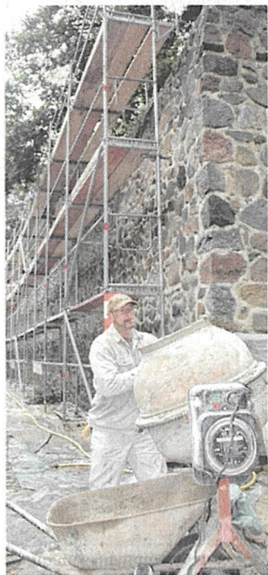
Die Baudenkmalpflege Prenzlau setzt der Stadtmauer in der 1. Ringstraße die Krone auf.
