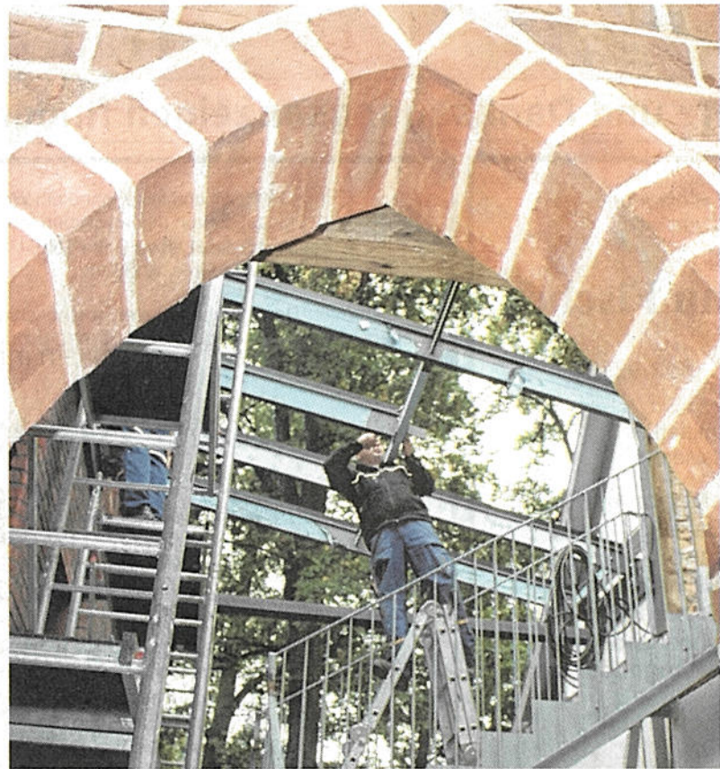
Meban-Monteur installieren die Stahlträger des Glasverbinders.
